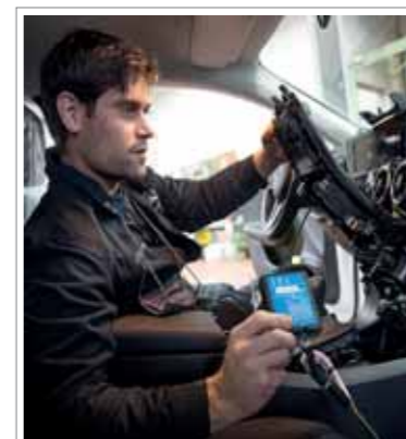
10.04 Uhr: Nachträglicher Einbau eines GPS- Fahrtenbuches, dazu wird die Mittelkonsole ausgebaut und mit dem Fahrzeugleitungssatz verbunden.
